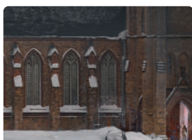
Архитектурные обмеры и обследования
